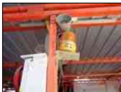
รูปที่ 41 อุปกรณ์แจ้งเหตุเตือนเพลิงไหม้โดยติดตั้งลำโพงกระจายเสียง
