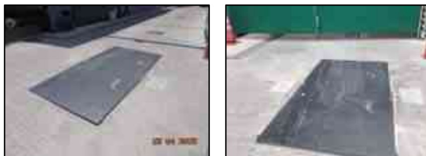
รูปที่ 20 แผ่นยางรองการวางวัสดุ และการปูแผ่นเหล็ก (Platform) เพื่อลดแรงสั่นสะเทือนจากการเดินรถภายในพื้นที่โครงการที่มีระดับพื้นต่างกัน
