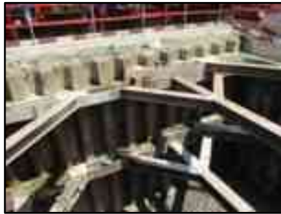
รูปที่ 23 ระบบป้องกันดินพัง ระบบ Pile wall และค้ำยันเหล็ก (Bracing)
