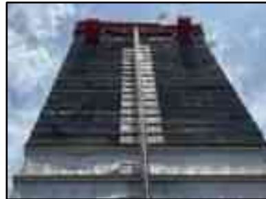
รูปที่ 11 ติดตั้งผ้าใบ Mesh sheet (ชนิดไม่ลามไฟ) คลุมรอบอาคารเท่ากับความสูงอาคาร ณ ขณะก่อสร้าง และติดตั้ง Sound Barrier Sheet เพื่อลดผลกระทบด้านเสียง
