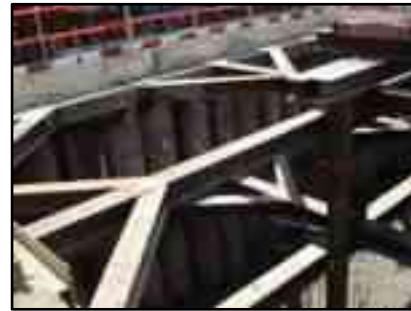
รูปที่ 23 ระบบป้องกันดินพัง ระบบ Pile wall และค้ำยันเหล็ก (Bracing)
