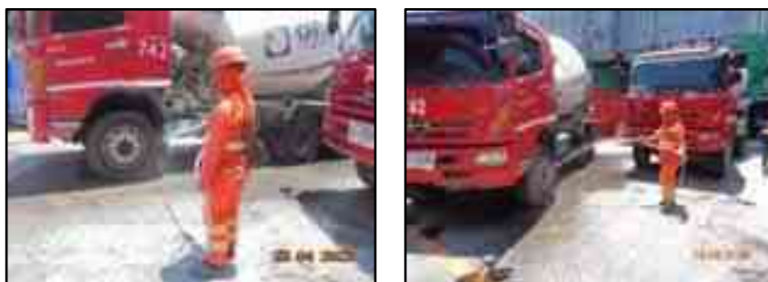
รูปที่ 17 จุดล้างล้อรถบรรทุกทุกทางเข้า-ออกพื้นที่โครงการ
