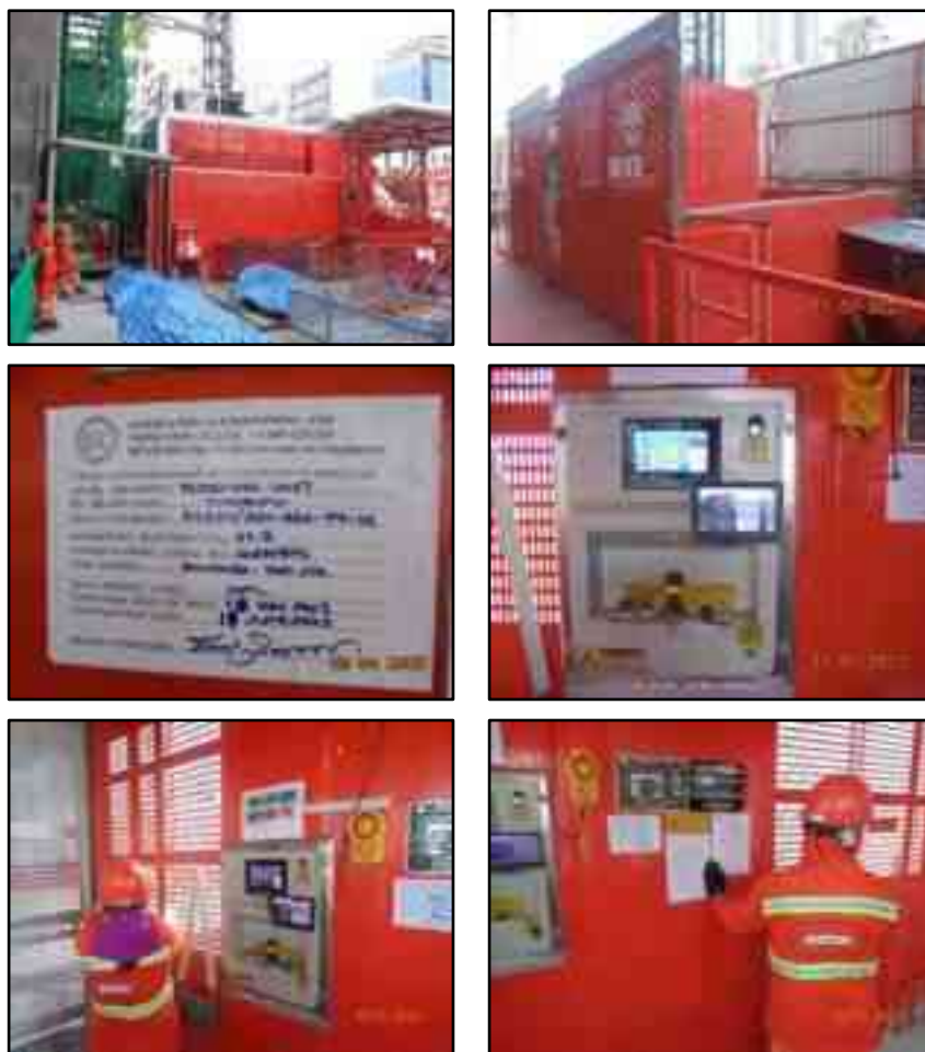
รูปที่ 56 ลิฟต์ขนส่งวัสดุชั่วคราว และลิฟต์โดยสารชั่วคราว
