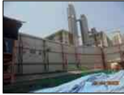
รูปที่ 3 รั้ว Metal Sheet ความสูง 6 เมตรรอบแนวเขตที่ดินของโครงการ
