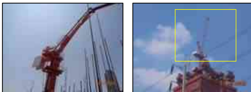
รูปที่ 57 เครนเป็นแบบพับแขนได้และแขนของเครนจะต้องอยู่เฉพาะภายในพื้นที่โครงการเท่านั้นไม่ล้ำไปยังพื้นที่ข้างเคียง
